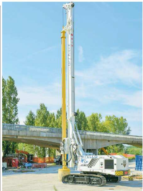
Questa settimana sono ripresi i lavori sul ponte di San Benedetto
